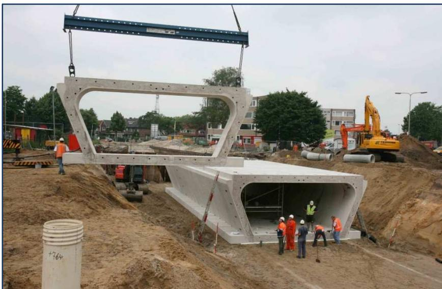
Als Weiterentwicklung der konventionellen, rechteckigen Form hat Romein Beton eine Spezialschalung konstruiert, mit der Elemente mit abgeschrägten Wänden gefertigt werden können. Die Unterführung wirkt dadurch räumlich ansprechender.
