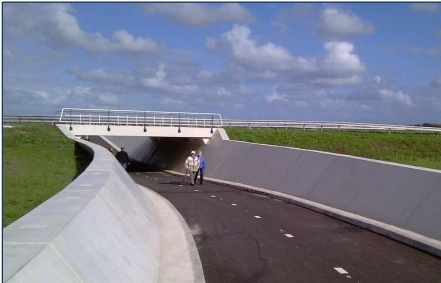
Den Entwurf, die Berechnungen, die Montage und das Spannen und Einspritzen der Betonfertigteile übernimmt Romein Beton selbst. Eine wasserdichte Ausführung ist deshalb garantiert.
